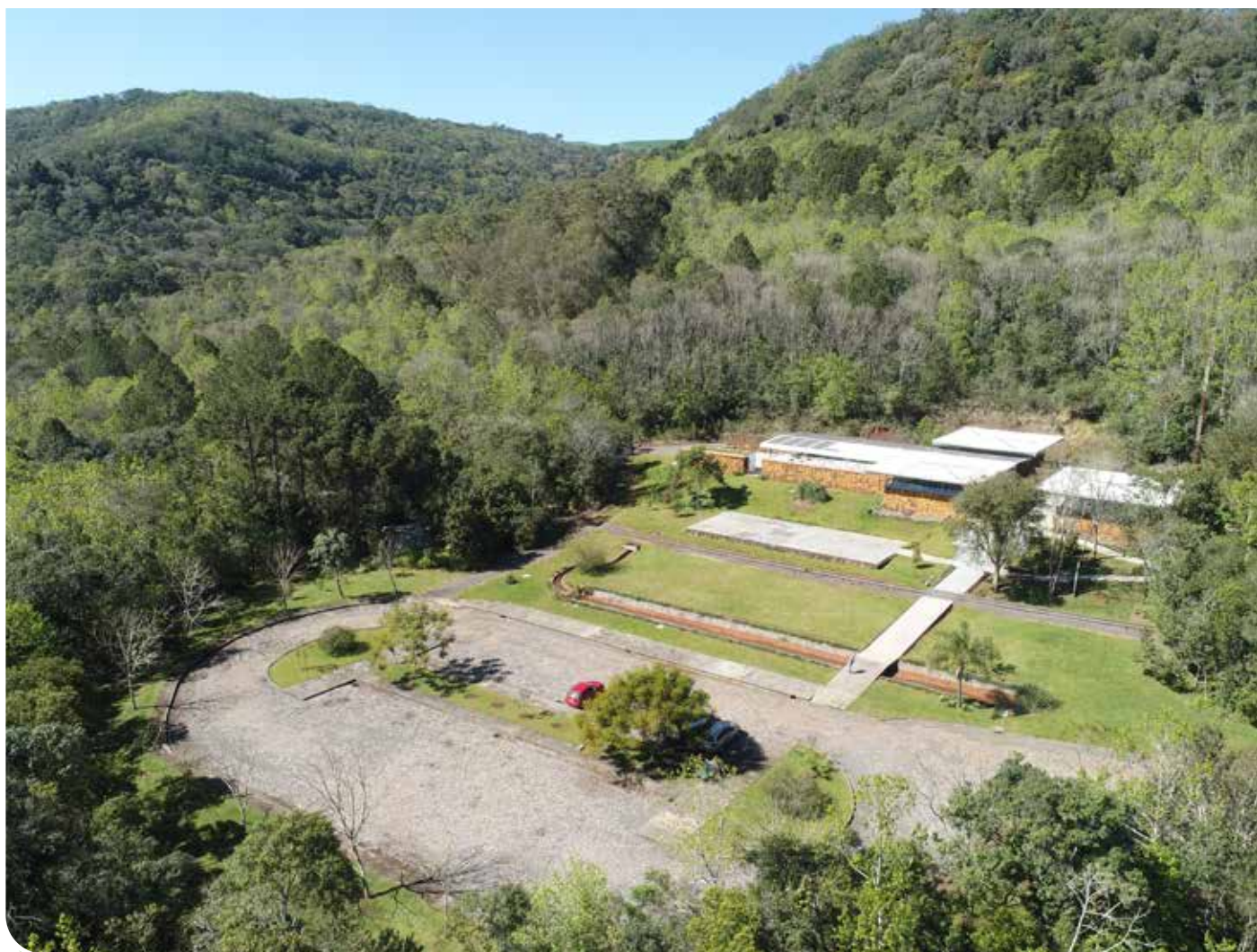
PNMTS - Vista aérea frontal da Sede do PNMTS
